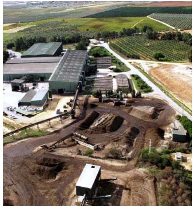
Foto 1: Vista general de las instalaciones
