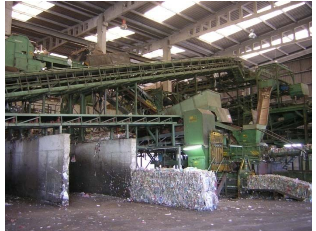
Foto 4. Planta de Recuperación de envases triaje de voluminosos. Los escombros son cribados y limpiados previo al aprovechamiento en el propio Centro de los áridos reciclados (R11). Los rechazos obtenidos son depositados en vertedero, después de la segregación de las fracciones utilizables.
