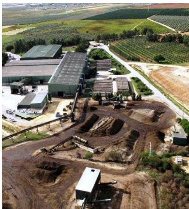
Foto 1: Vista general de las instalaciones
