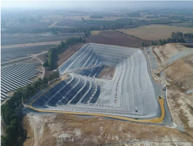
Foto 5. Vertedero en explotación
