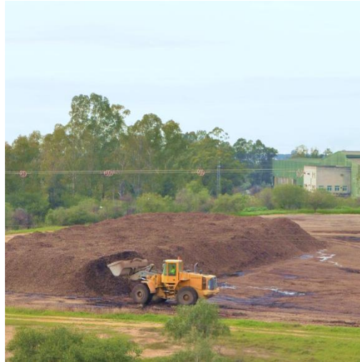
Foto 9: Parque de maduración
